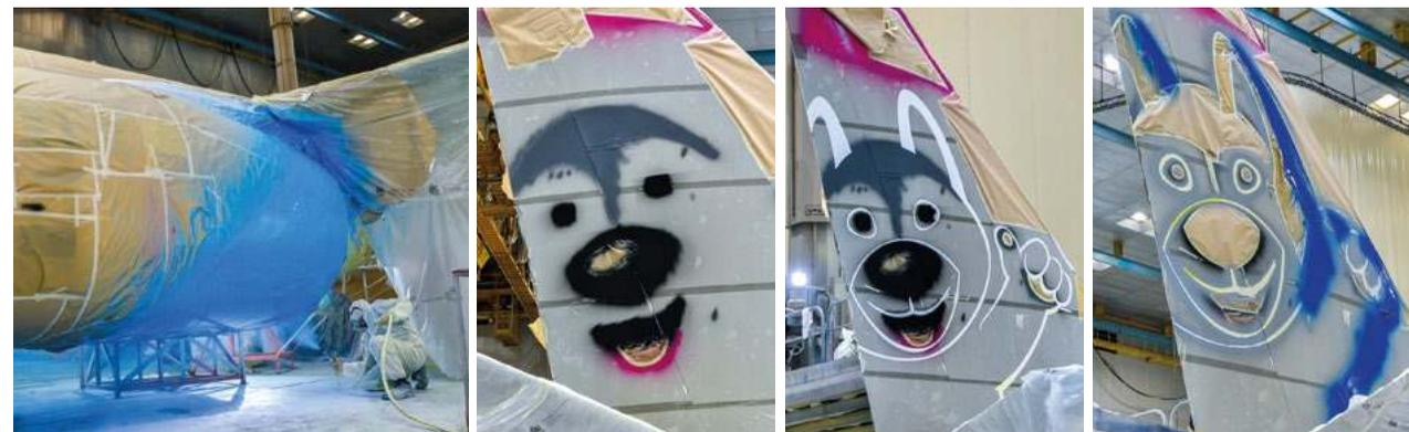
Процесс покраски борта электростатический, то есть у краски и корпуса самолета разноименные заряды, потому краска притягивается и ложится более равномерно.
