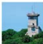
Смотровая башня на горе Ахун
