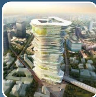
Пандусы могут быть разной высоты и ширины, что позволяет создавать в пределах здания различные функциональные зоны. Поддерживают пандусы шесть вертикальных колонн, в которых разместятся лифты для быстрой доставки персонала, грузовые транспортеры для подъема быстровозводимых модульных элементов здания и различные конструктивные элементы здания, включая электрические кабели и оборудование, мусоропроводы, отопительные системы и водопровод.
