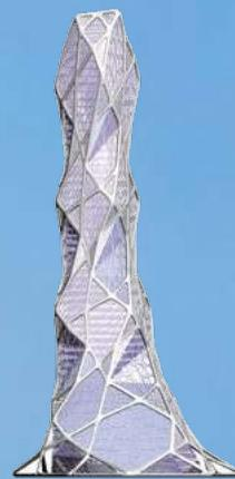
Башня будет состоять из 12 вертикальных кварталов высотой метров по 80, связывать их будут перекрытия-сдержки, которые станут своеобразной несущей конструкцией для каждого очередного уровневых кварталов. Перемещать людей внутри вертикального города должны 400 горизонтальных и вертикальных лифтов со скоростью 15 м/с, то есть с первого на последний этаж можно будет подняться в среднем за две минуты.
