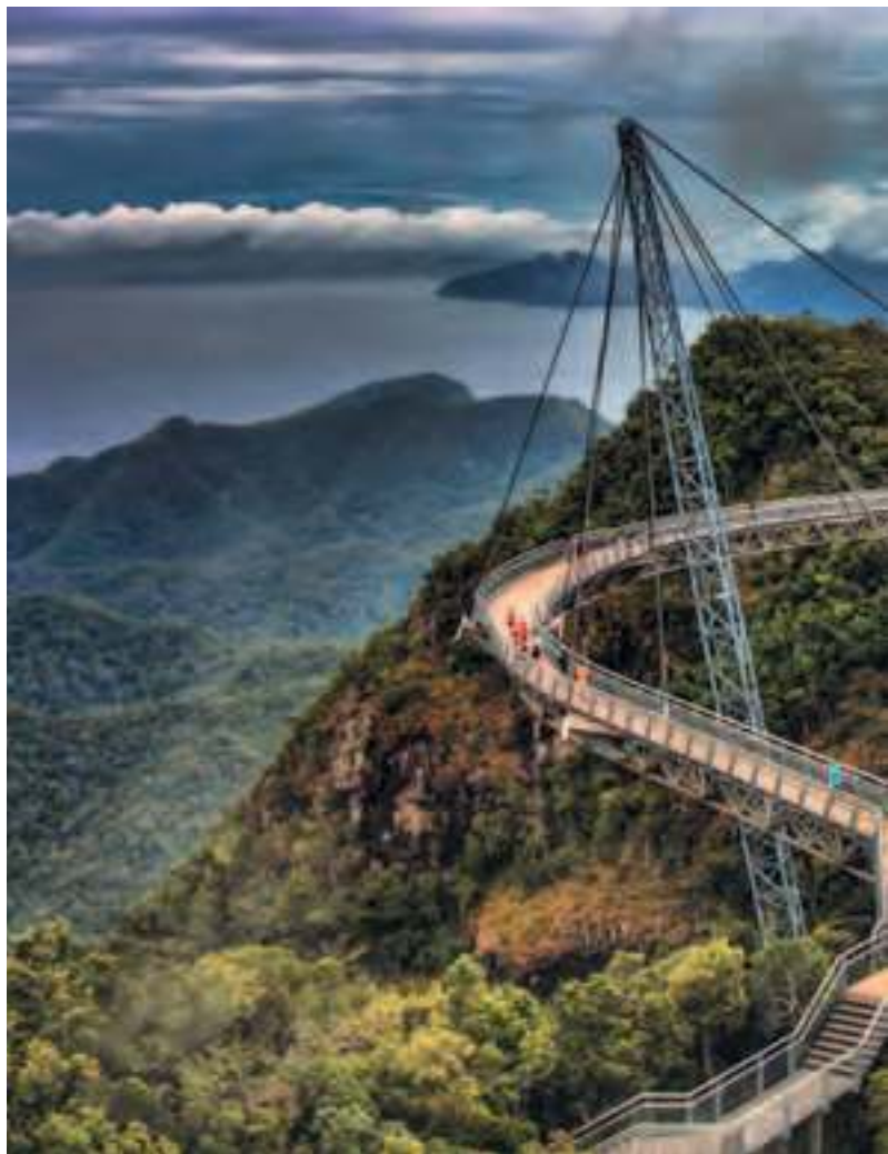
ЭТО ЧУДО ИНЖЕНЕРНОЙ МЫСЛИ ДЕРЖИТСЯ ВСЕГО НА ОДНОЙ ВЕРТИКАЛЬНОЙ ОПОРЕ. LANGKAWI SKY BRIDGE, МАЛАЙЗИЯ
